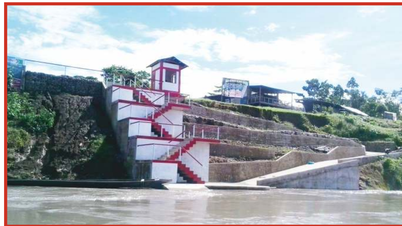
PUERTO DE LA CN NUEVA VIDA, DONDE ESTÁ LA GARITA DE CONTROL DE TRÁNSITO FLUVIAL
