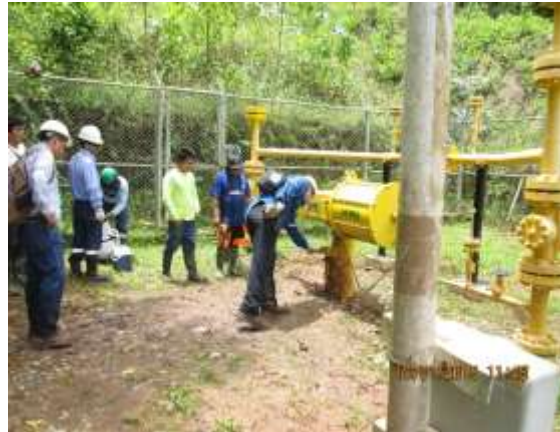
El Ing. Gallegos señala el punto de Line Break donde se produjo el incidente de la emisión de gas
