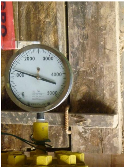
Manómetros indicando los niveles de presión normales aproximados de operatividad.
