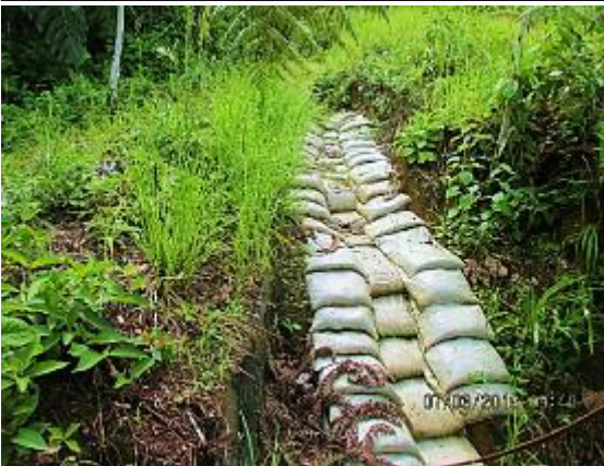
En estas imágenes se observa que los cortacorrientes se encuentran en buen estado y reciben mantenimiento por parte de la empresa INMAC.
