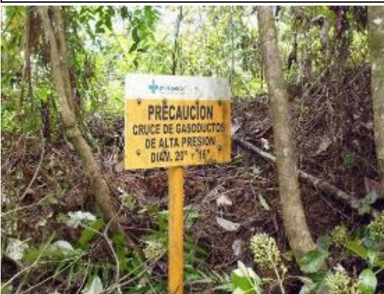
En esta otra imagen se observa un letrero de advertencia en buen estado en el derecho de vía.
