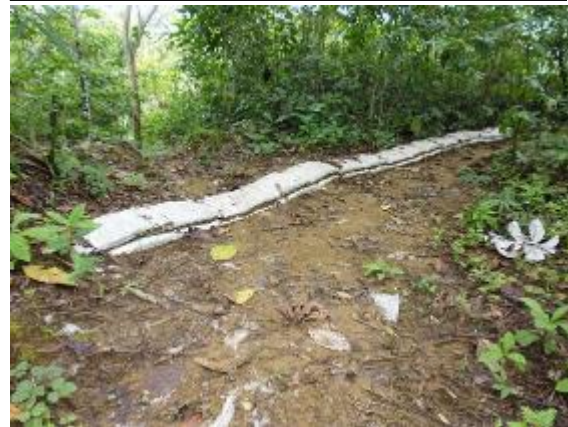
En estas imágenes se observa que los cortacorrientes se encuentran en buen estado y reciben mantenimiento por parte de la empresa INMAC.
