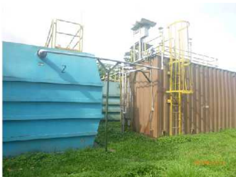
Fotografía 4: Cámara de ecuilización (contenedor marrón) en PTARD C1 en CBM (Fuente: PPC)
