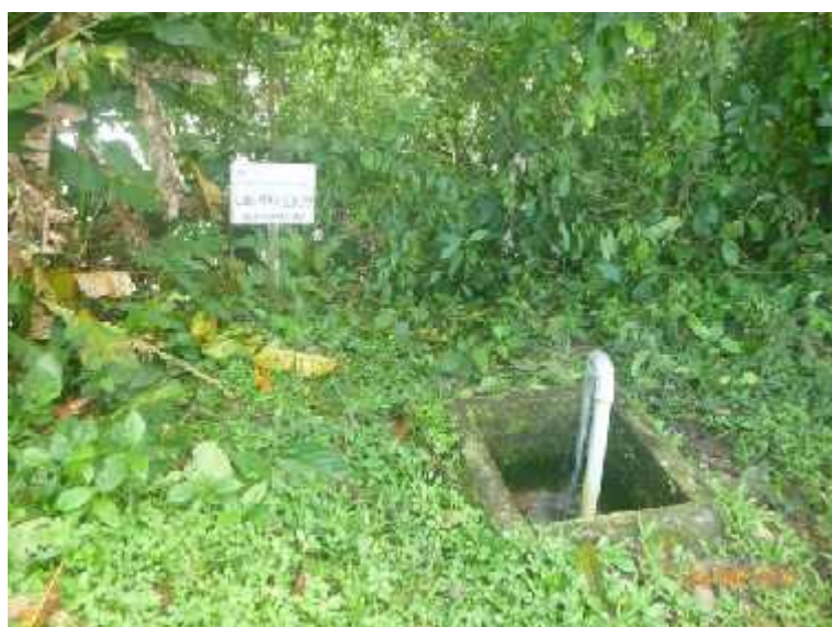
Fotografía 9: Punto de vertimiento de efluente doméstico de PTARD C1 en CBM (Fuente: PPC)
