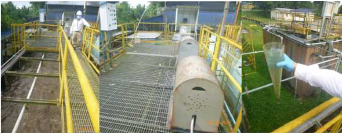
Fotografía 05: Aguas residuales domésticas en tratamiento, aireadores y muestra de agua residual en proceso de la Cámara de Aireación de PTARD C1 en CBM (Fuente: PPC)
