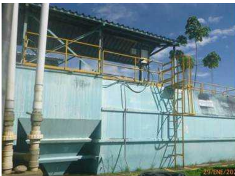
Fotografía 12: Vista externa de PTARD C4 en CBM (Fuente: PPC)
