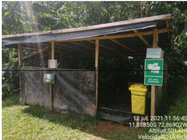
Fotografía 7: PIT de Aceites con medidas preventivas en CV 17+500 (Fuente: PPC)
