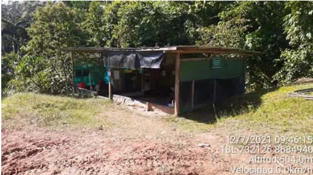
Fotografía 5: Vista externa del almacén temporal de residuos en CV 17+500 (Fuente: PPC)
