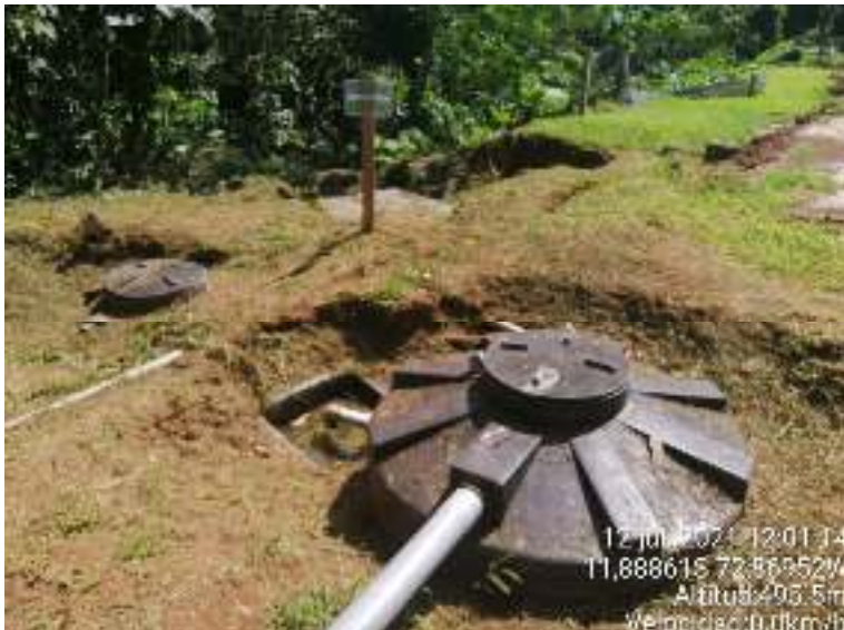
Fotografía 15: Biodigestores para el tratamiento de aguas residuales (Fuente: PPC)
