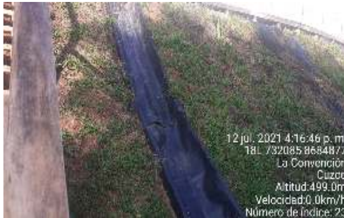
Fotografía 16: Habilitación de canaletas en CV 17+500 (Fuente: PPC)
