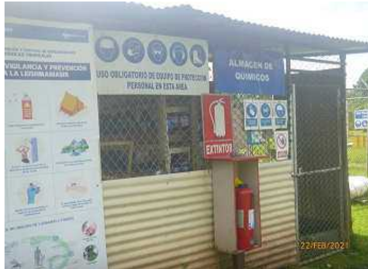
Fotografía 18: Almacén de sustancias químicas en Locación Pagoreni A (Fuente: PPC)
