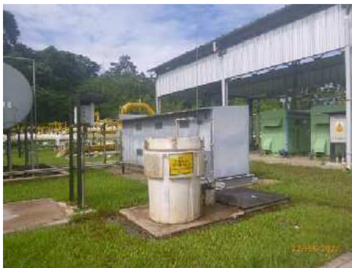
Fotografía 11: Kit contra derrames en área de servicios auxiliares en Locación Pagoreni A (Fuente: PPC)
