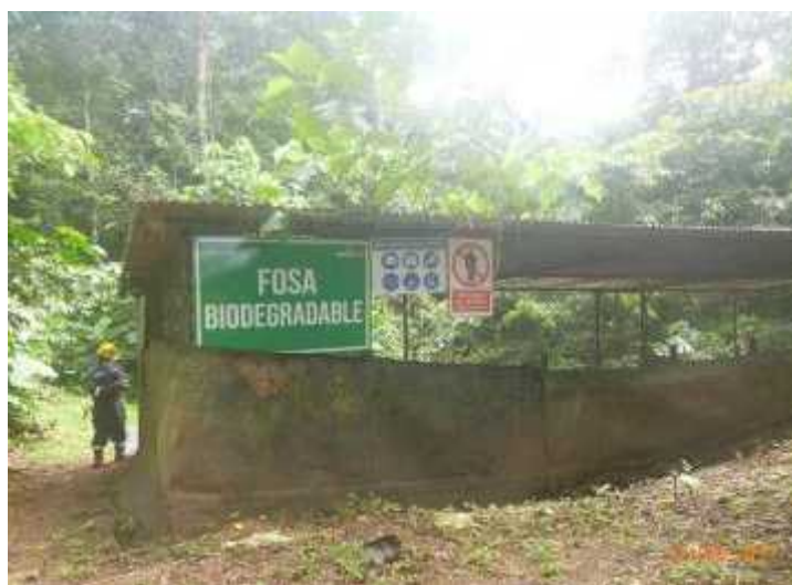
Fotografía 21: Vista externa de la fosa biodegradable en Locación Pagoreni A (Fuente: PPC)
