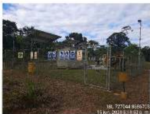
LVB 24507 (Margen derecho de la quebrada Porocari)
