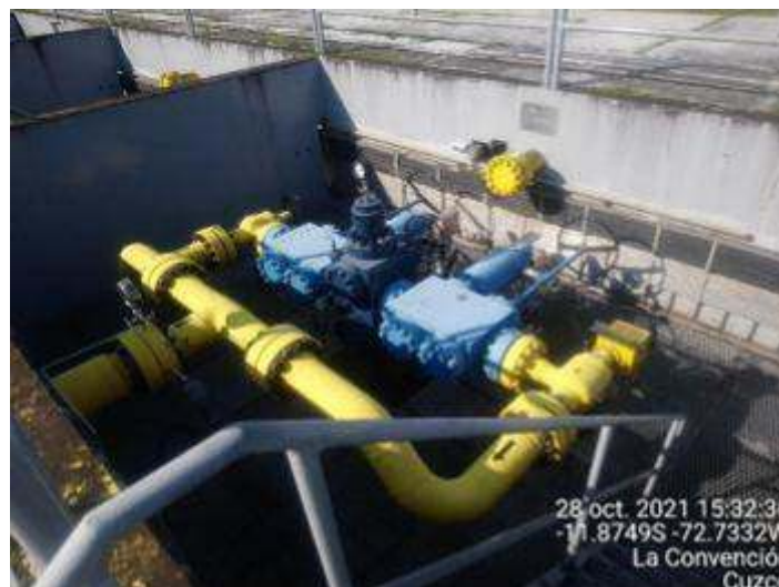
Fotografía 5: Área del Cellar (Pozo CR-1R) en la Locación Cashiriari 1 (Fuente: PPC)
