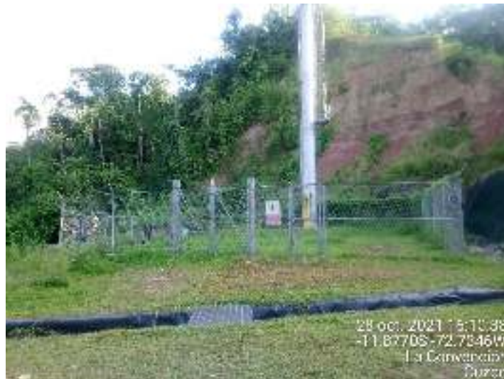
Fotografía 19: Área del Flare en Locación Cashiriari 1 (Fuente: PPC)
