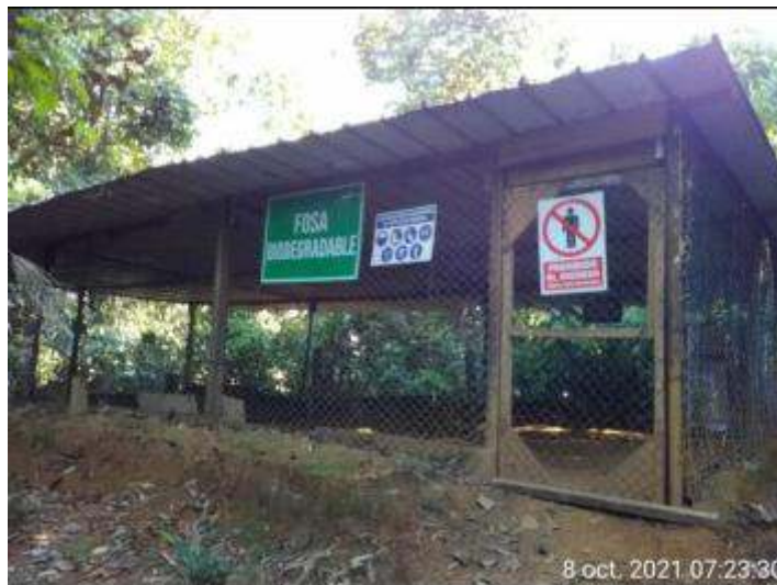
Fotografía 30: Vista externa de la fosa biodegradable en Locación Cashiriari 1 (Fuente: PPC)
