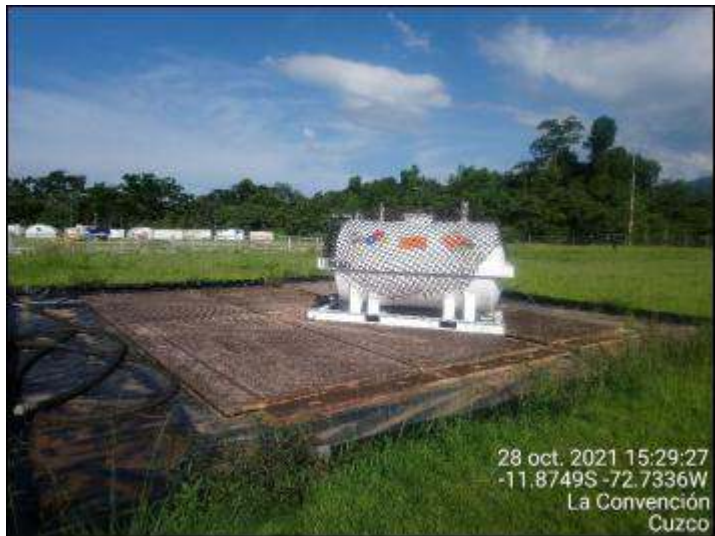
Fotografía 26: Pit de tanques de combustible helitransportables en Locación Cashiriari 1 (Fuente: PPC)
