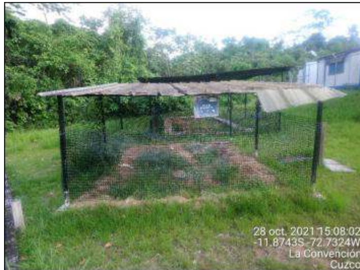
Fotografía 29: Área de Biodigestor en Locación Cashiriari 1 (Fuente: PPC)
