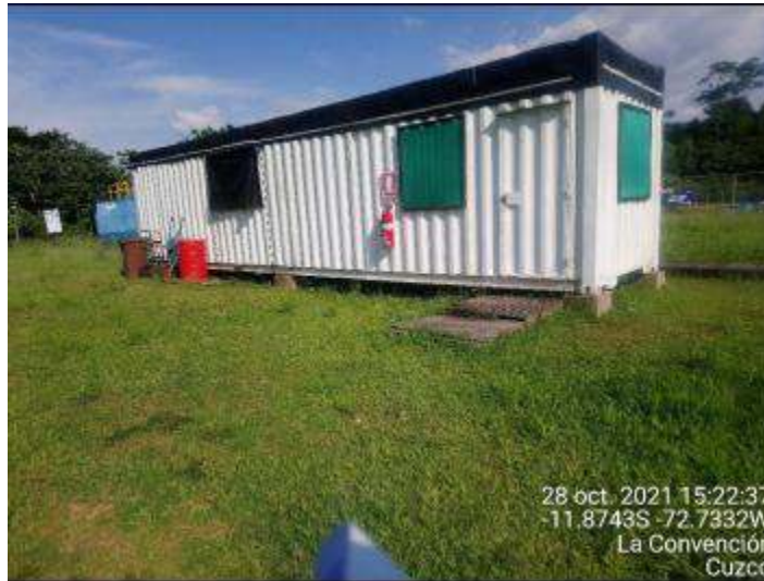
Fotografía 20: Vista externa del almacén temporal de residuos en Locación Cashiriari 1 (Fuente: PPC)
