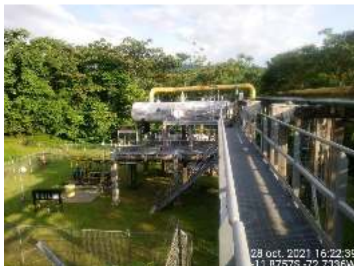
Fotografía 15: Sistema de drenajes presurizados y no presurizados del área del KOD en Locación Cashiriari 1 (Fuente: PPC)
