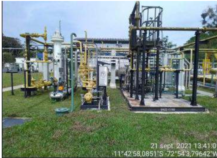
Fotografía 10: Sistema de fuel gas en Pagoreni A (Fuente: PPC)
