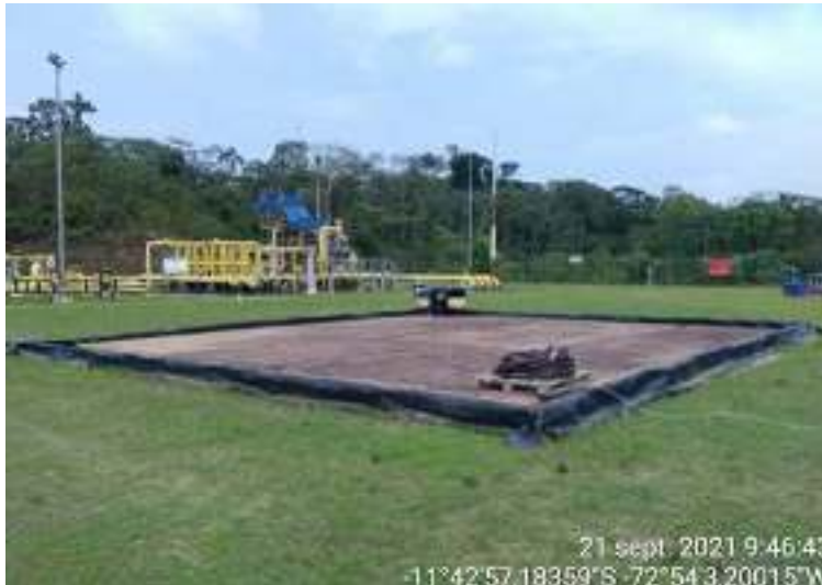
Fotografía 30: Pit de tanques de combustible helitransportables en Locación Pagoreni A en Malvinas (Fuente: PPC)
