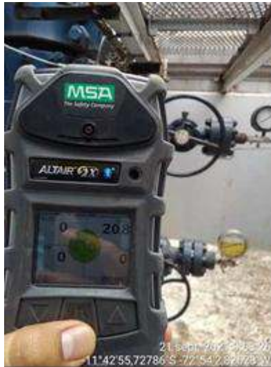
Fotografía 6: Medición del LEL en pozos de la Locación Pagoreni A (Fuente: PPC)
