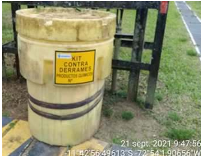
Fotografía 42: Kit antiderrame en área de generador en Locación Pagoreni A (Fuente: PPC)
