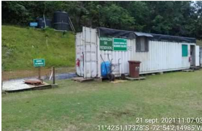
Fotografía 22: Vista externa del almacén temporal de residuos en Locación Pagoreni A (Fuente: PPC)
