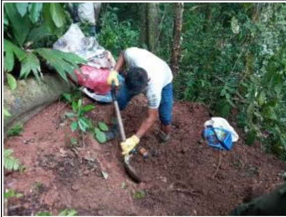
Otra vista del desenterrado de residuos en el sitio de la PK 29+580
