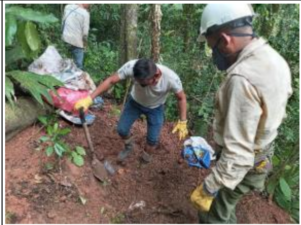
La basura que fue encontrándose se colocó a un costado de la excavación.
